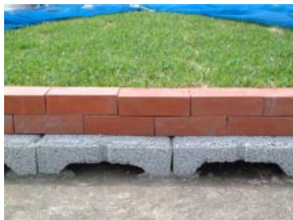
写真2. 遮蔽ブロックに芝生を設置
