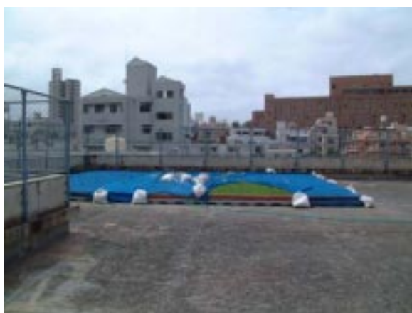
写真1. 実験校舎(開南小学校)の屋上
